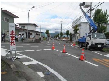
学校北東側 T字路 ライン引き・コーンの設置 車の速度抑制につながる
